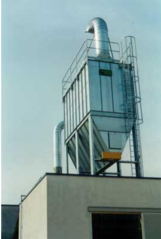
Il sistema filtrante di pulizia ed estrazione automatica è dotato dei filtri Jet ed è basato su una struttura autoportante in travi zincate a caldo.
